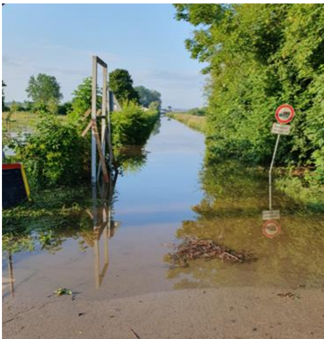
Die Asylunterkunft am Forstmahd wurde komplett geflutet und war nur noch mit dem Boot erreichbar. Das Gebäude
